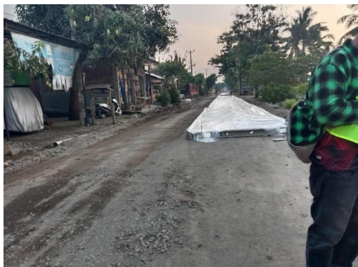
Gambar 14. Proses pemasangan tulangan dan bekisting
