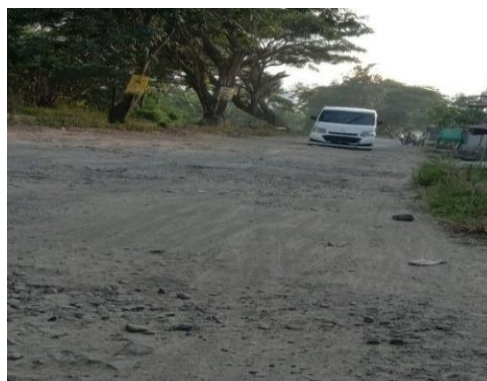
Gambar 4. Pelepasan butir ( raveling )
