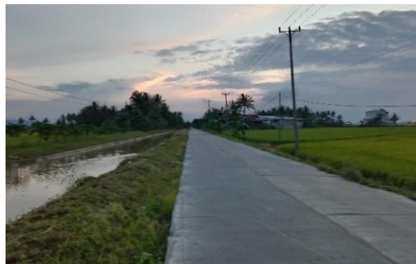
Gambar 12. Kondisi lebar jalan setelah rehabilitasi
