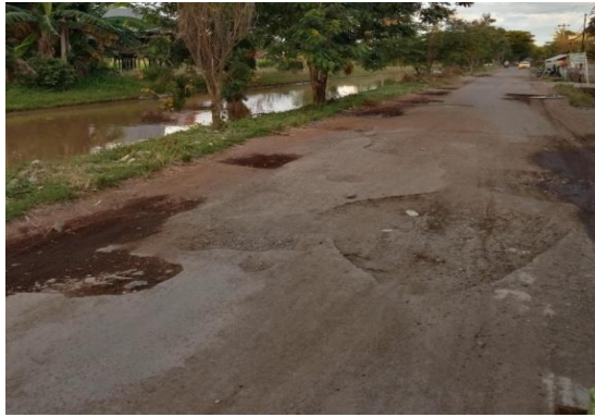
Gambar 5. Pengelupasan lapis permukaan
