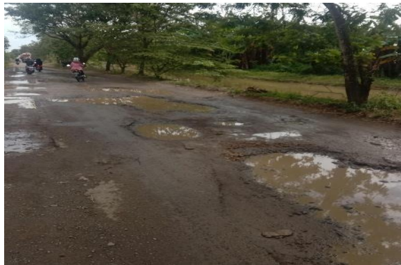
Gambar 3. Kerusakan lubang
