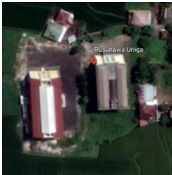
Gambar 2: Lokasi proyek Sumber: Google Earth
